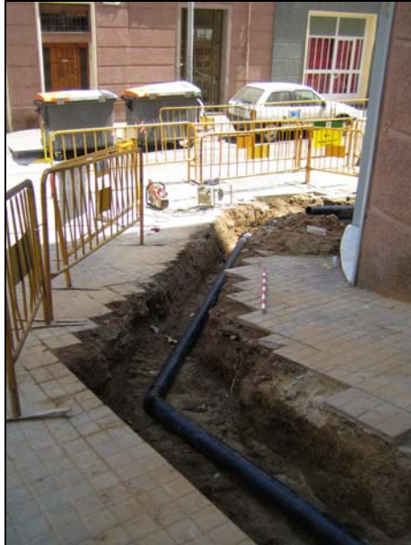
FOTO 5. Tram d'unió de la rasa 1
