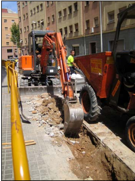
FOTO 1. Inici del tram de la rasa 1 en direcció est-oest
