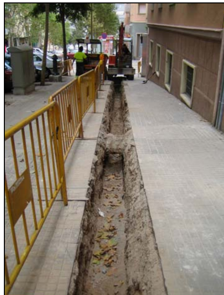
FOTO 4. Tram nord-sud de la rasa 1 finalitzat
